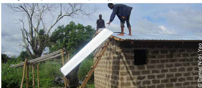
Toiture en tôles ondulées. (Tao-Zéou)
