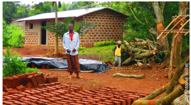
Les ménages ont participé au processus de construction de bout en bout, en fabriquant des briques, en préparant du mortier et en s'acquittant d'autres tâches.
